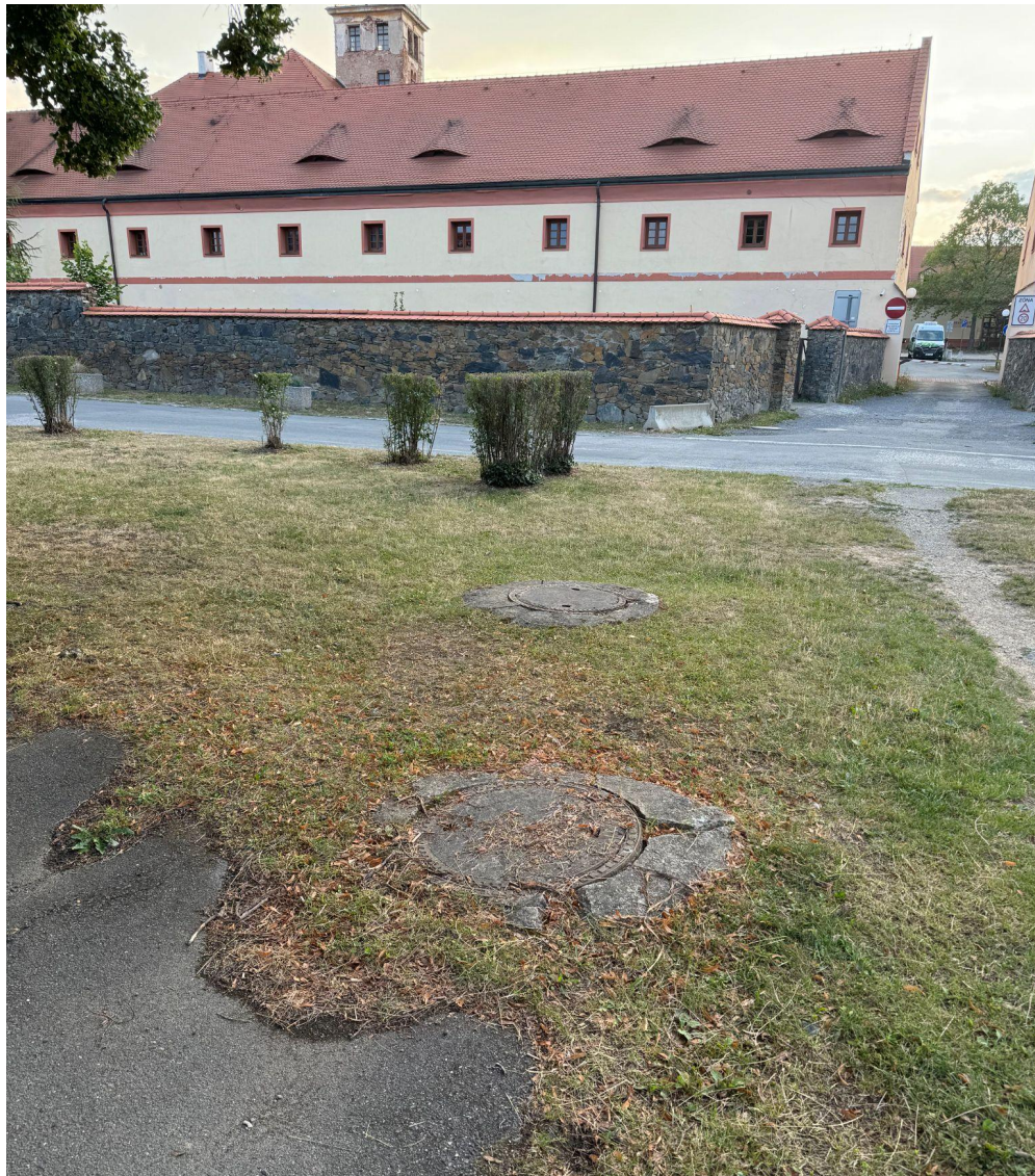
současný stav obetonávky
