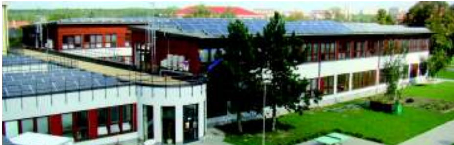
Fotovoltaická elektrárna na střeše nové přístavby Základní školy (foto my).
