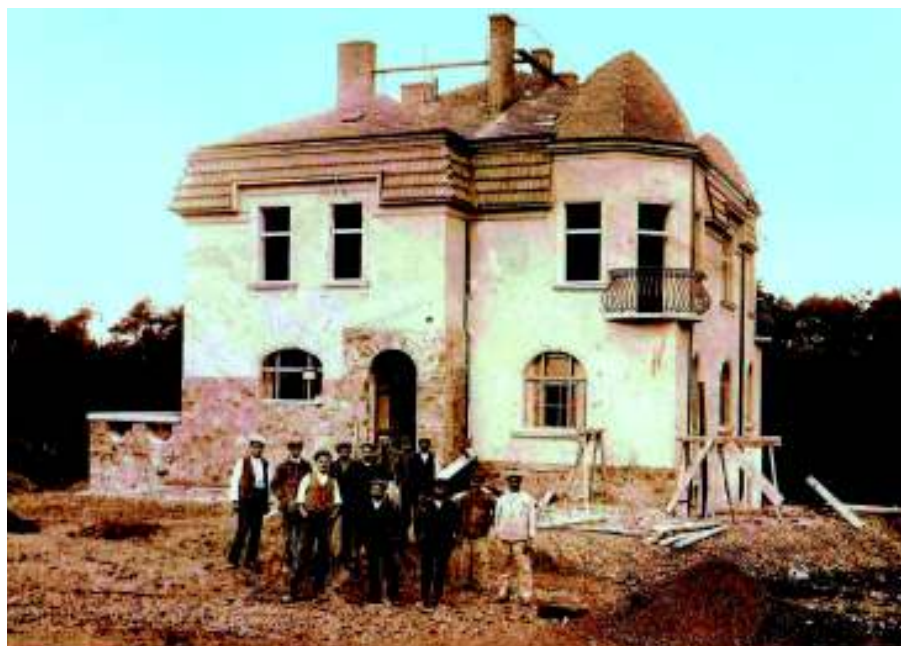
Vila č. p. 178 těsně před dokončením na podzim roku 1922 (archiv p. Jiří Vraný).
